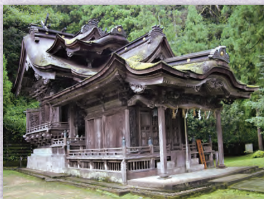
檜皮葺(ひわだぶき)の屋根が美しい下宮の社殿
